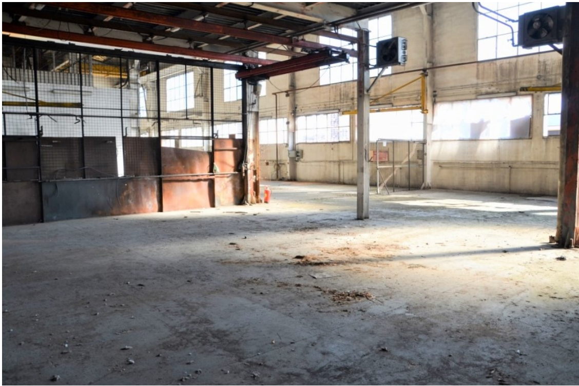
Usine Pillard avant travaux, ©Les 8 Pillards
