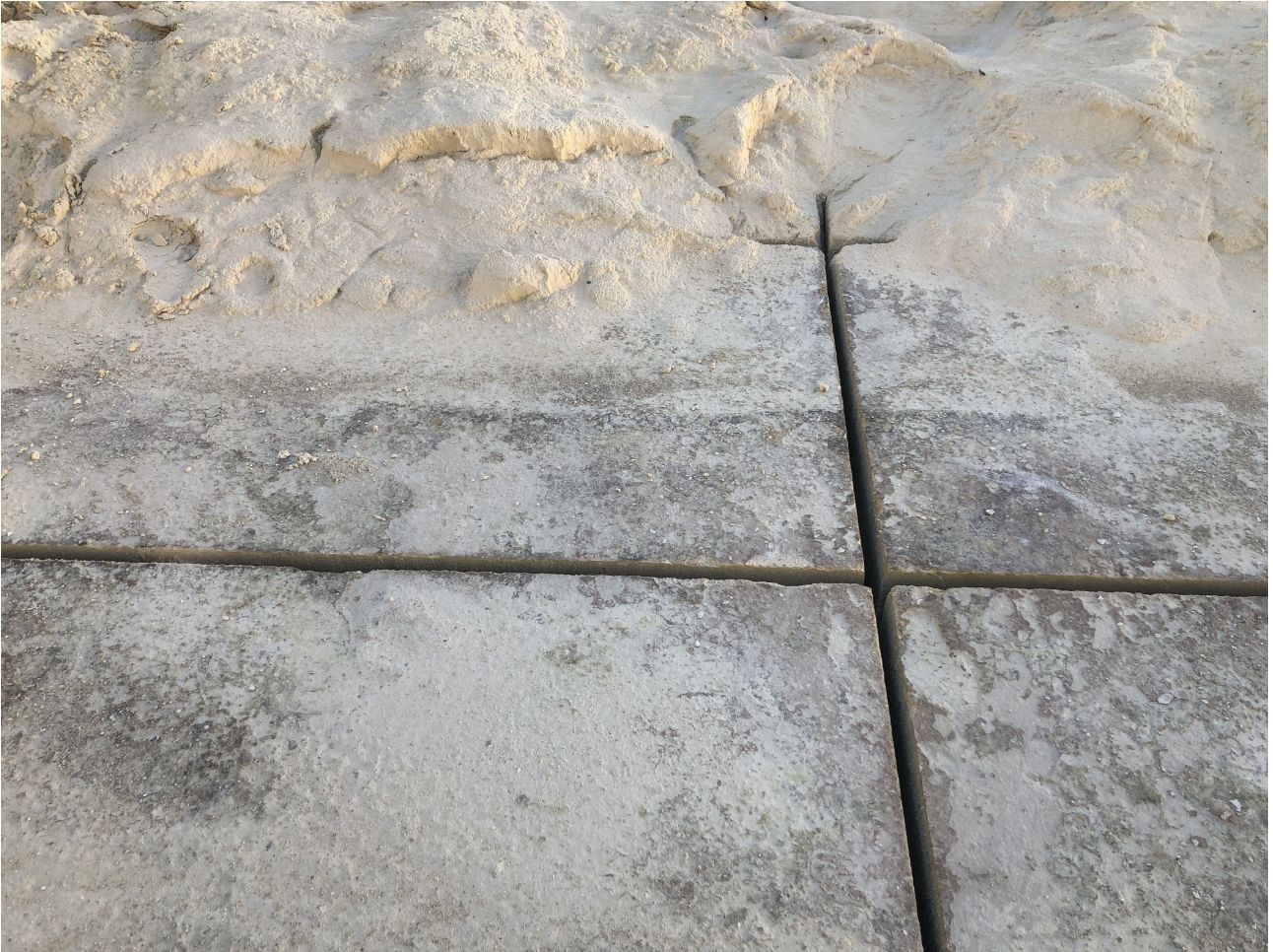
Fig. 6 — Anne-Valérie Gasc, Carrière de Fontvieille (vues de l'amphithéâtre - documents de travail), lieu-dit Les Taillades , visite sur site du 14 février 2025.
