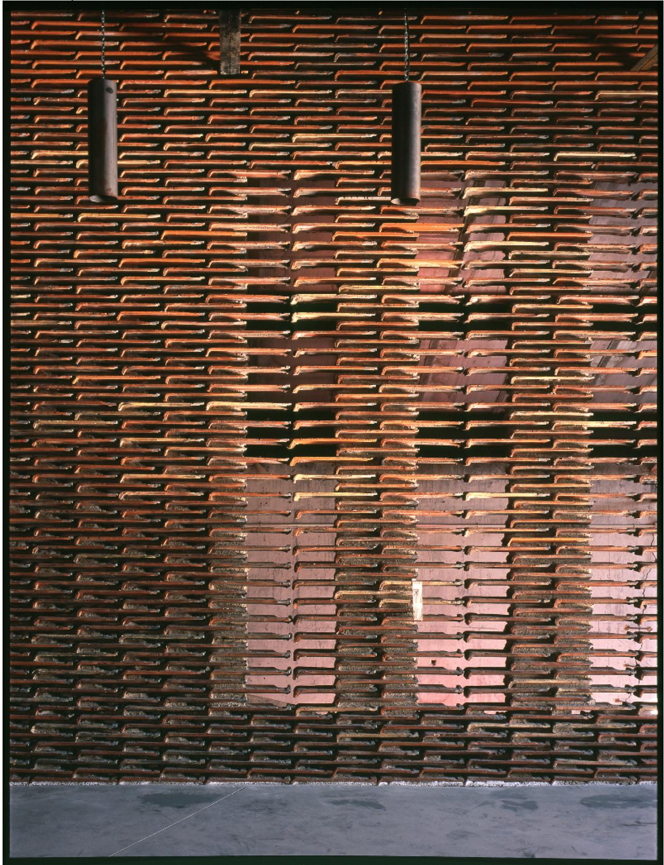
**Fig. 4** : Détail des cloisons en tuiles des Abattoirs 8B, Madrid (Espagne), 2009, projet conçu par Arturo Franco avec la collaboration des ouvriers du chantier, © Carlos Piñar.
