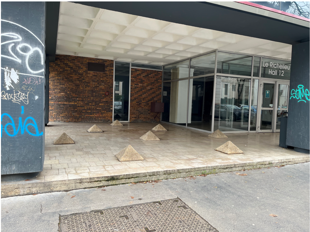
Figure 1. Installation inhospitalière sous le porche d'un immeuble à Dijon. Photo personnelle.
