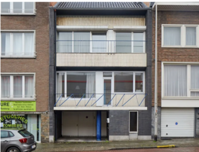
Fig. 3: Façade de la Maison Watelet à Woluwe-Saint-Lambert (Bruxelles), 2020.
