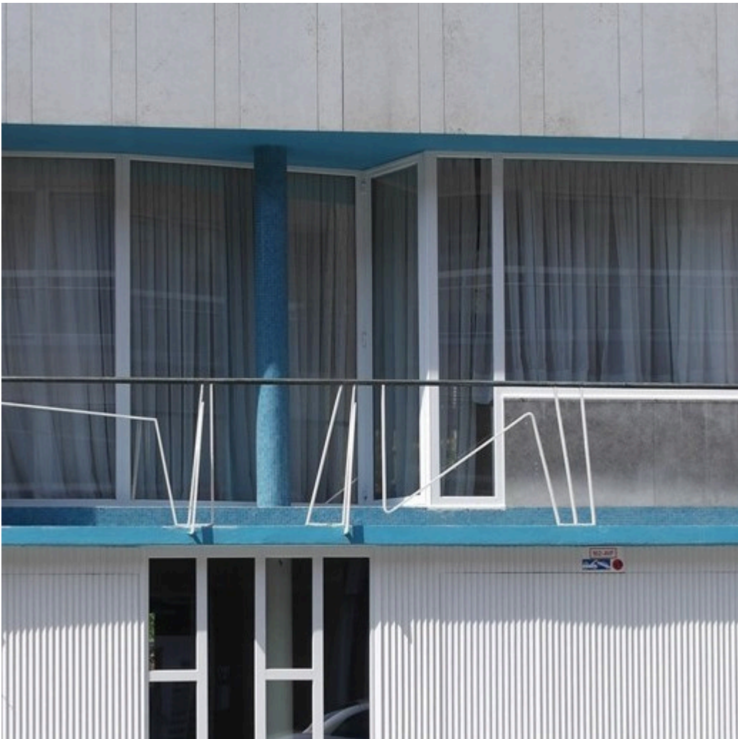
Fig. 6: Détails de façade de la maison Durieu à Molenbeek-Saint-Jean (Bruxelles), 2009. Architectes: Simone Guillissen-Hoa & Jacques Dupuis, 1954-55. Source: Modernisme ludique en Belgique, Atomium
