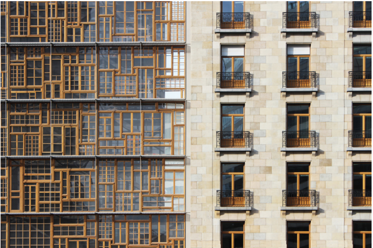
Fig. 6 : Détail de la façade d'Europa, Bruxelles (Belgique), 2015, projet conçu par Philippe Samyn & Partners avec l'aide d'un brocanteur, © Philippe Samyn and Partners architects & engineers, Lead and Design Partner with Studio Valle Progettazioni architects, Buro Happold Limited engineers, photo : Quentin Olbrechts.
